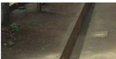
Figura 4. Drenaje del alrededor de la planta
