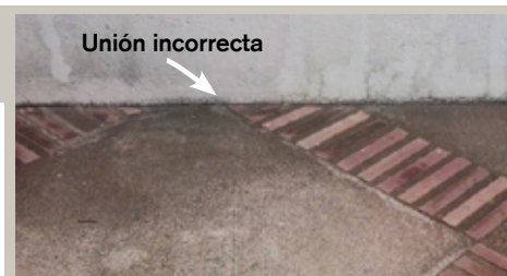
Figura 20. Unión piso pared sin curvatura
