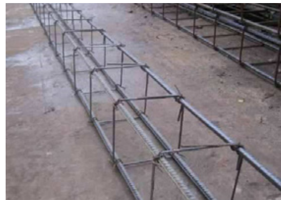
Figura 17. Estructura de hierro
