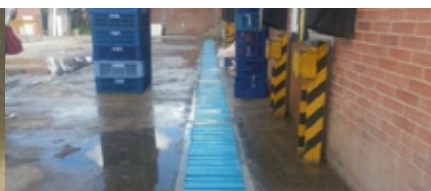
Figura 5. Drenajes externos con rejillas de protección de perlines
