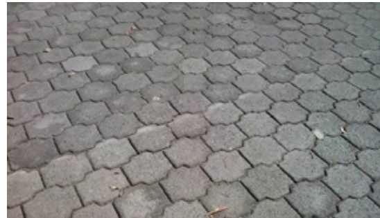
Figura 1. Adoquinado de los alrededores de la planta
